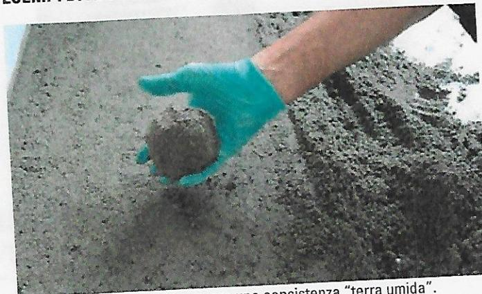
Il massetto impastato deve avere una consistenza "terra umida".
